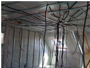
Installation d'un circuit électrique dans une maison
